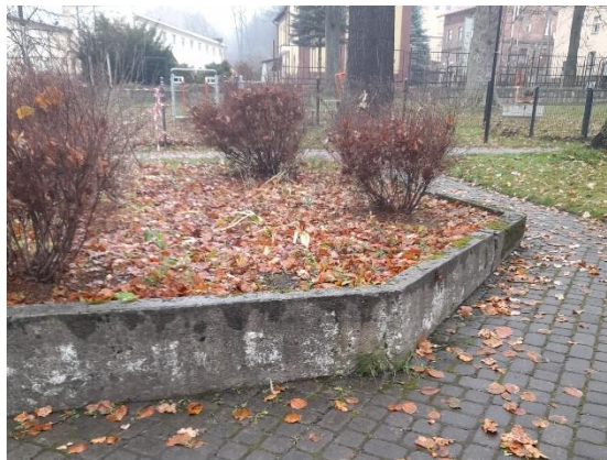
Fot. 10 Murek rabatowy z betonu
